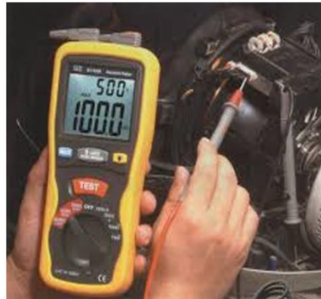
Gambar 7-19. Mengukur tahanan isolasi.
